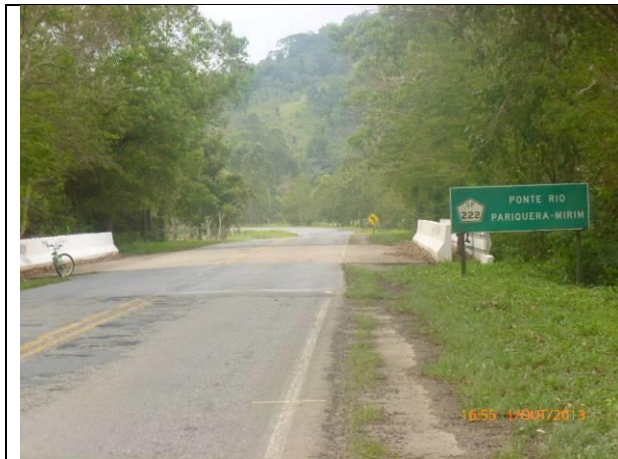
Km 96+400 – Vista da ponte sobre o rio Pariquera-Mirim (Foto 13).
