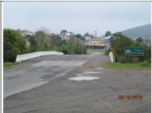
Km 115+300 – Vista da ponte sobre o rio Canha (Foto 14).
