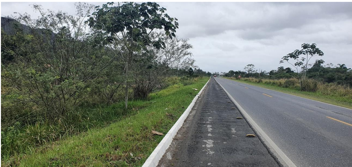
Foto 109 – Ciclovia junto à rodovia em trecho próximo ao km 53.
