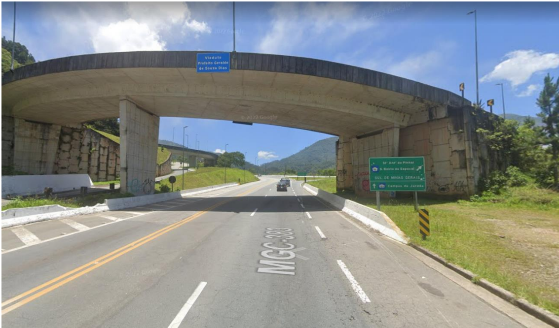
Foto 96 – Viaduto de acesso a Santo Antonio do Pinhal, km 33,5.
