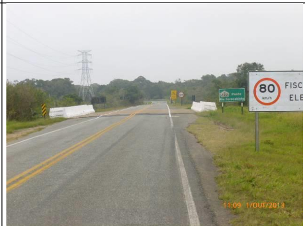
Km 61+500 – Vista da ponte sobre o córrego Sorocabinha (Foto 12).
