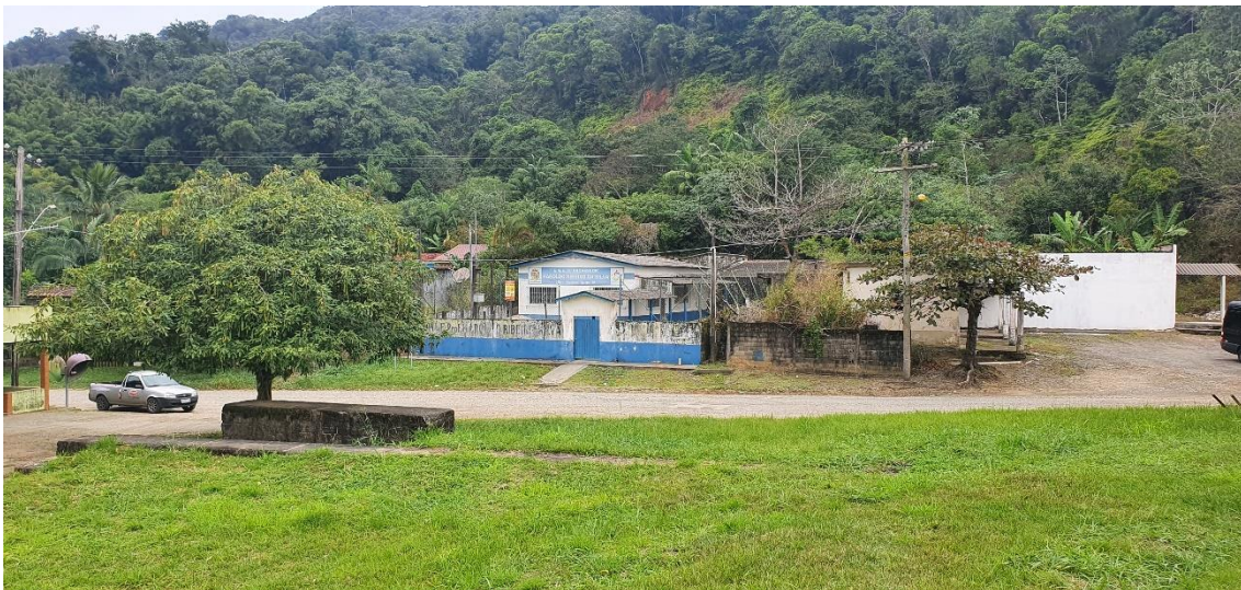
Foto 107 – Vista de escola no bairro dos Engenhos no município de Iguape.
