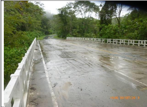
Km 2+400 – Vista da ponte sobre o córrego Vale da Mutuca (Foto 9).
