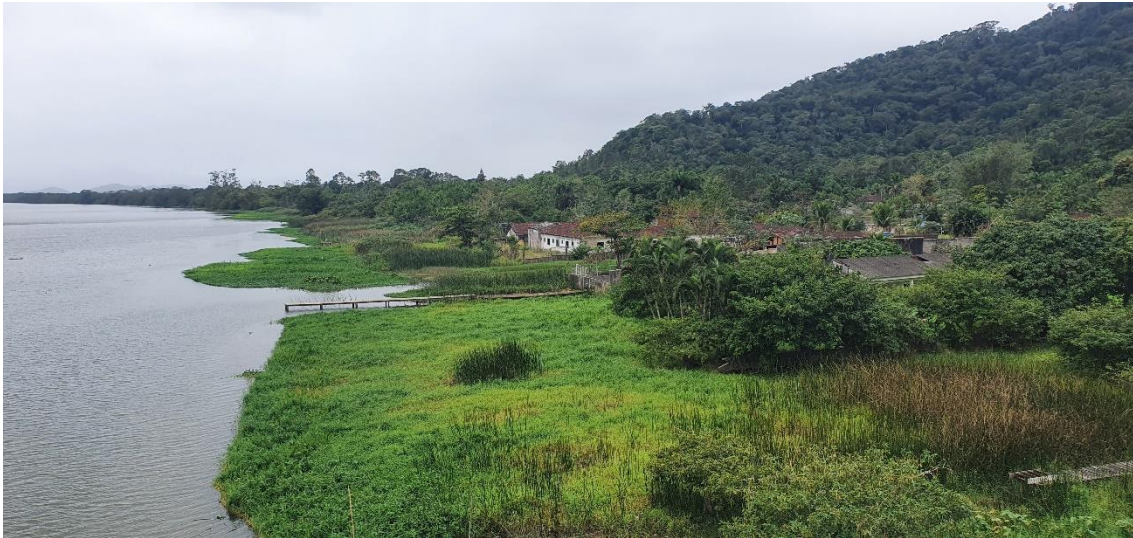
Foto 108 – Vista de estruturas da produção pesqueira deterioradas, aparentemente abandonadas.
