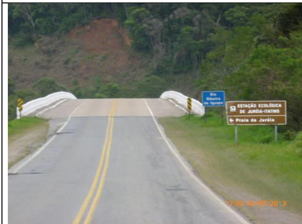
Km 45+900 – Vista da ponte sobre o rio Ribeira de Iguape (Foto 11).
