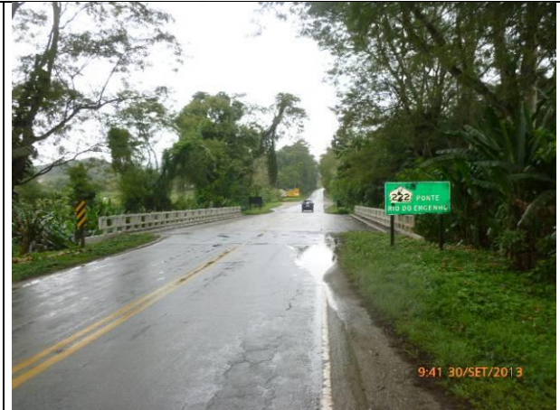
Km 0+600 – Vista da ponte sobre o rio do Engenho (Foto 8).
