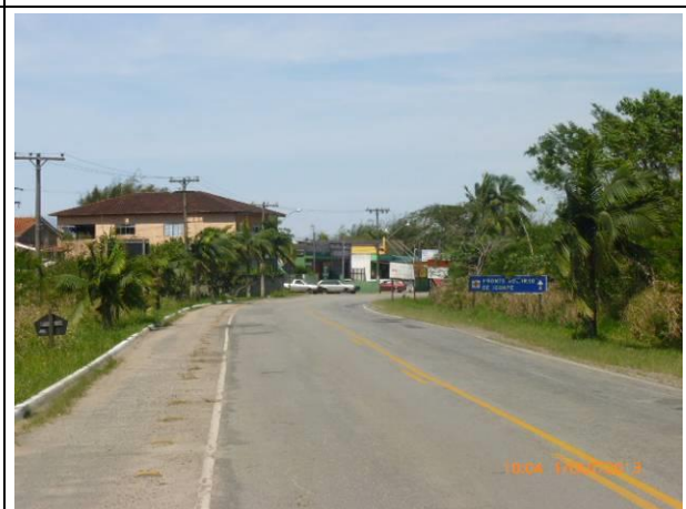
Km 51+540 – Vista do início da ciclovia - LE (Foto 36).
