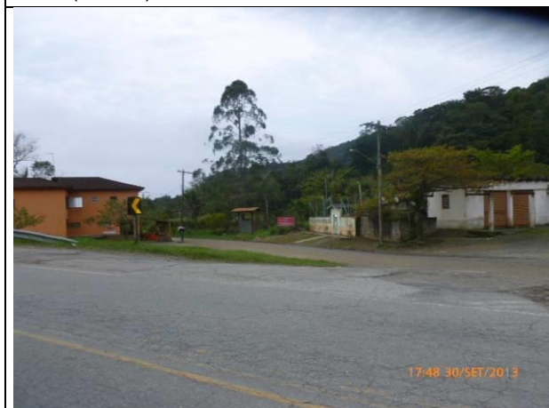
Km 46+300 – Vista do dispositivo de interseção em nível/Acesso à Estrada da Barra (vicinal) – LE (Foto 5).
