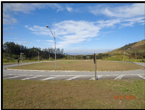
Foto 3 - Km 25+650-Dispositivo desnível (acesso à Pindamonhangaba)
