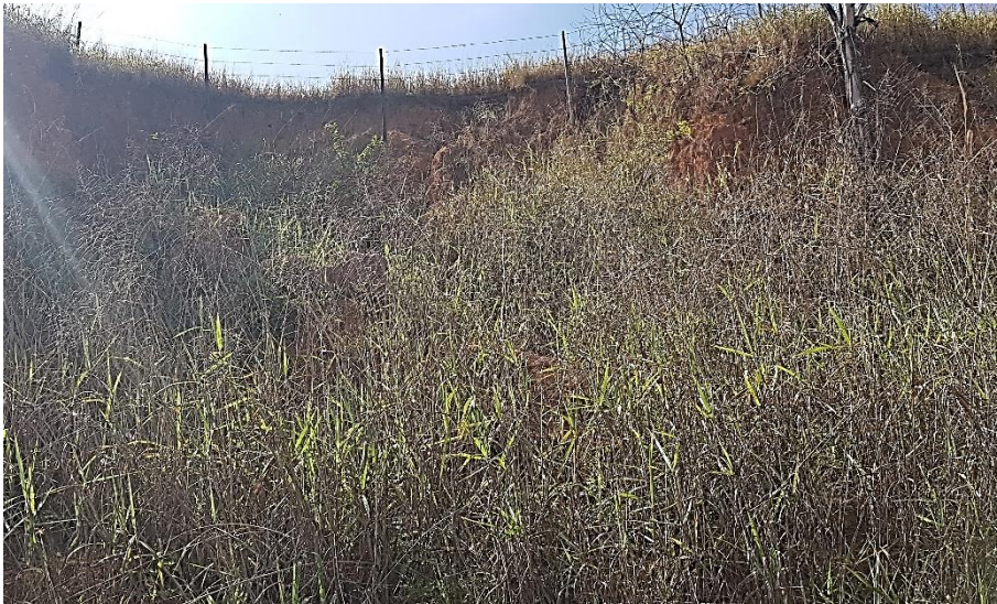
Foto 127 – Processo erosivo identificado na Rodovia SP-123
