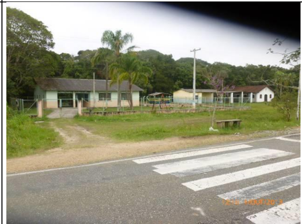
Km 71+000 – Vista da Escola Prof. Antônio Tadeu Pereira Cunha - LE (Foto 34).
