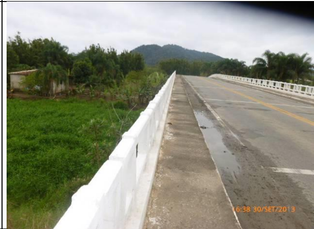
Km 37+000 – Vista da ponte sobre o rio Pequeno (Foto 10).
