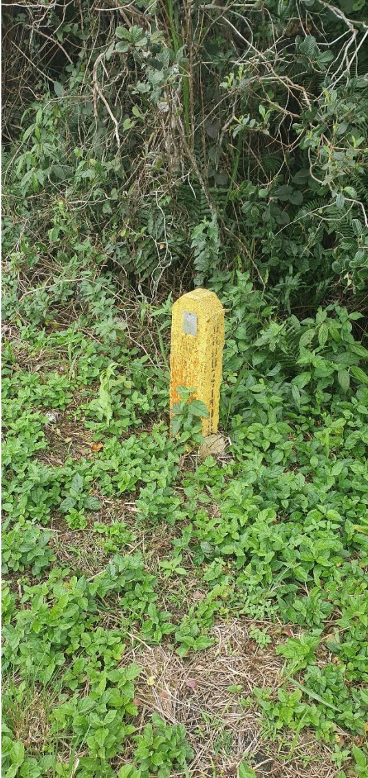
Foto 113 – Marco de aviso de gasoduto implantado próximo à rodovia.
