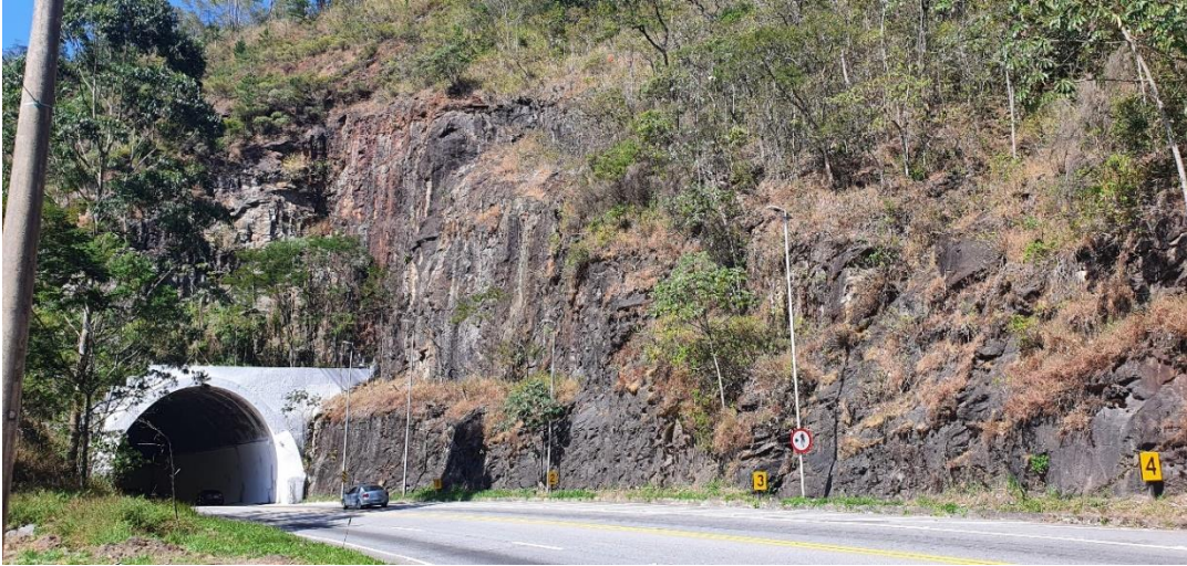
Foto 94 – Túnel no trecho de serra, km 31.
