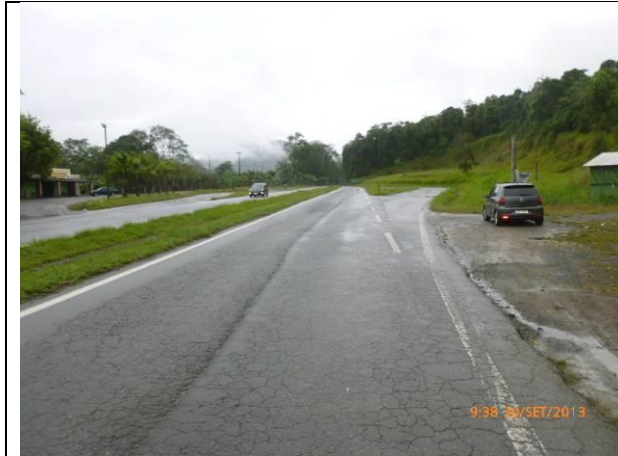
Km 0+200 – Vista do início do trecho (Foto 1).
