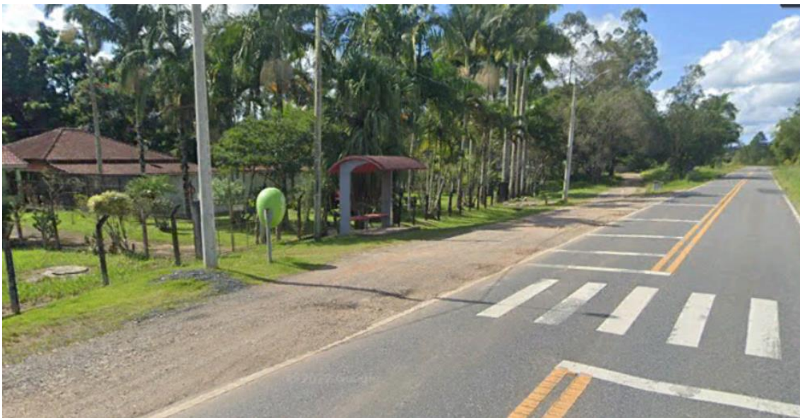
Foto 117 – Edificações e estruturas de serviços públicos na SP-222, km 95.
