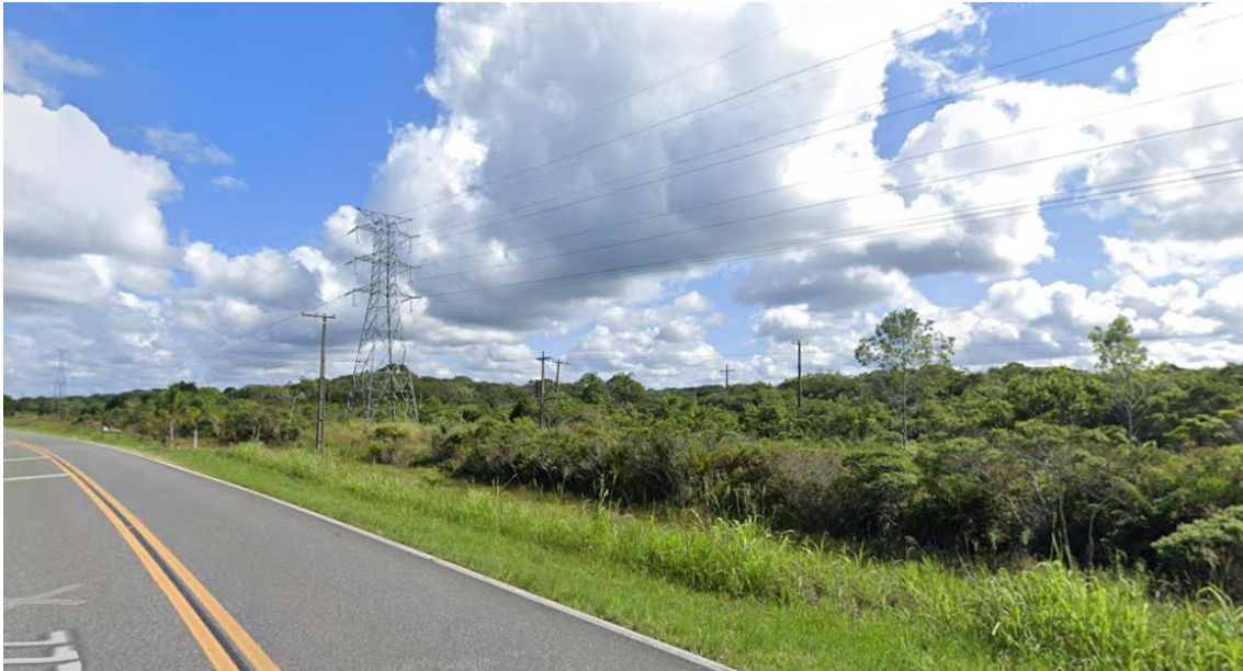
Foto 112 – Vista de torre de linha de transmissão ao longo da rodovia, no trecho entre Iguape e Parquera-Açu.
