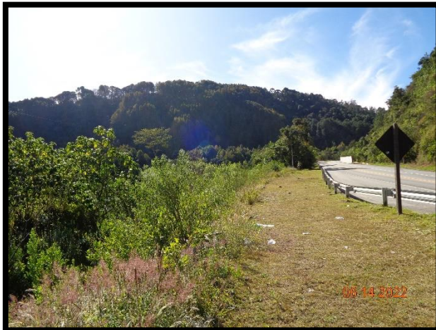
Foto 5 - Km 43+400_LE-Implantação de passagem superior (ciclopista)
