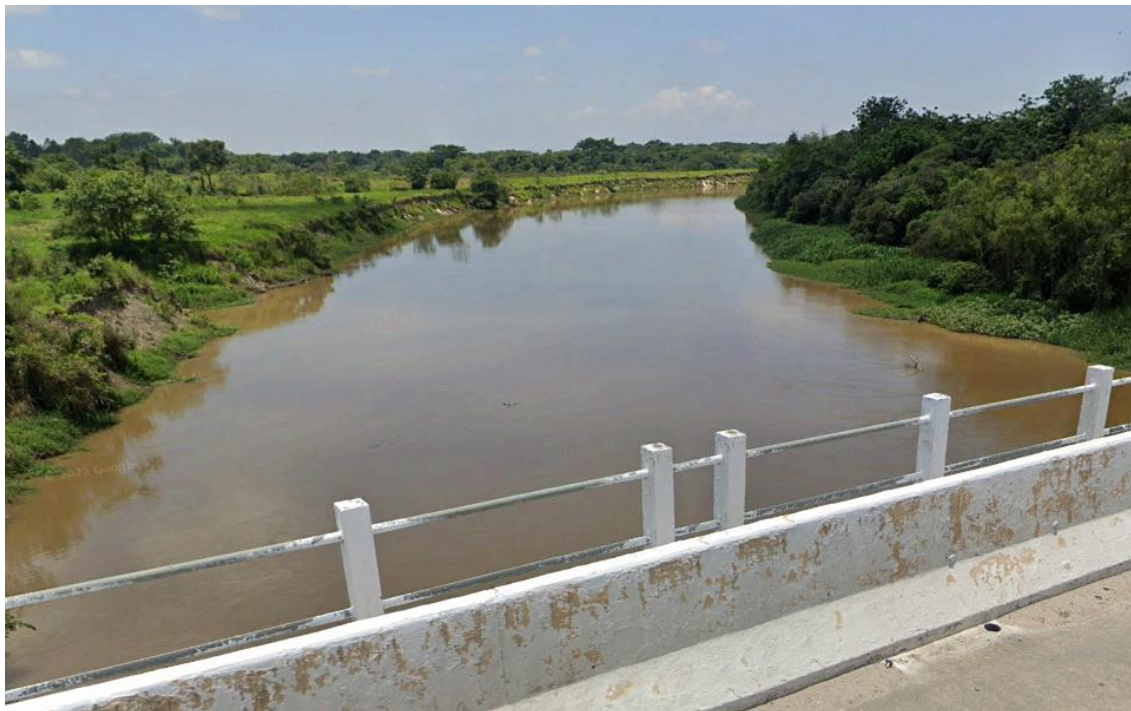
Foto 12 – Passagem sobre o rio Paraíba do Sul
