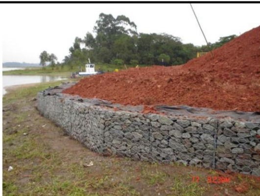
Fotos 5 e 6: Controle com muro de gabião, formando muros de diversos formatos e manta geotêxtil implantada no ponto mais baixo de aterro, que podem ser utilizadas para prevenir processos erosivos e carreamento de sedimentos.
