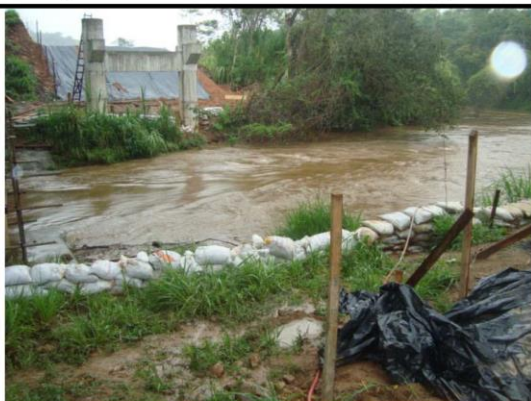
Fotos 3 e 4: Controle com linhas de sacaria. Podem ser utilizadas para conter e prevenir processos erosivos, escorregamentos e carreamento de sedimentos para fora da área de intervenção.
