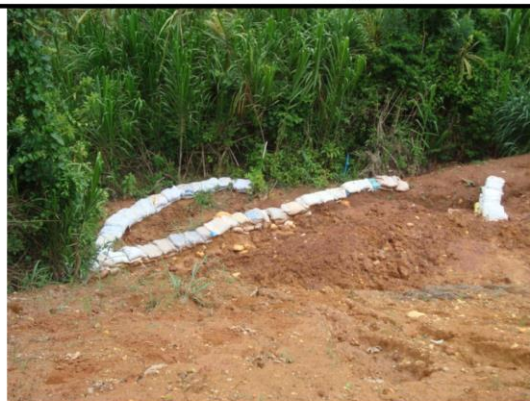
Fotos 3 e 4: Controle com linhas de sacaria. Podem ser utilizadas para conter e prevenir processos erosivos, escorregamentos e carreamento de sedimentos para fora da área de intervenção.
