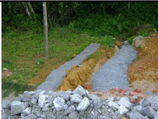
Fotos 1 e 2: Técnica de diques e leiras de rachão e revestimento vegetal – São medidas preventivas contra a instalação de processos erosivos e carreamento de solo, pois se minimiza a susceptibilidade à dinâmica de águas pluviais.
