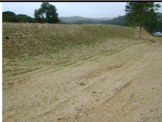
Fotos 1 e 2: Técnica de diques e leiras de rachão e revestimento vegetal – São medidas preventivas contra a instalação de processos erosivos e carreamento de solo, pois se minimiza a susceptibilidade à dinâmica de águas pluviais.
