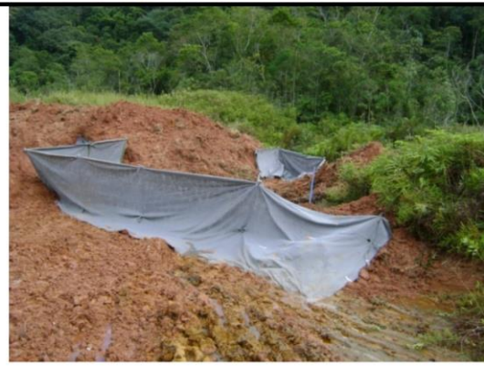
Fotos 5 e 6: Controle com muro de gabião, formando muros de diversos formatos e manta geotêxtil implantada no ponto mais baixo de aterro, que podem ser utilizadas para prevenir processos erosivos e carreamento de sedimentos.
