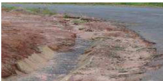
Figura 29: Erosão de borda (SAFL)
