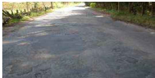
Figura 22: Severidade Regular (BGS)
