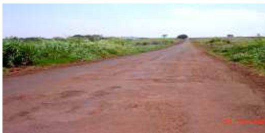
Figura 19: Vista geral defeito revestimento
