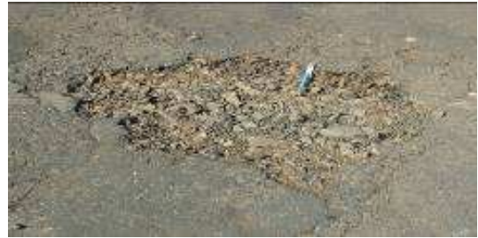
Figura 18: Defeito Revestimento (BGS)
