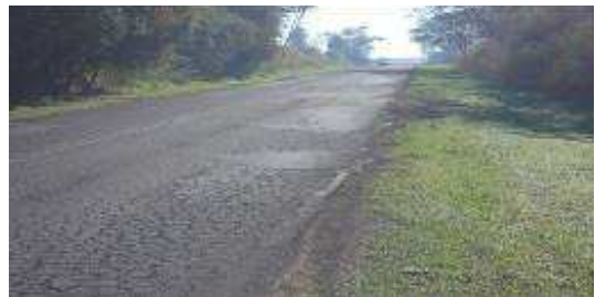
Figura 24: Severidade Mau (Granular)
