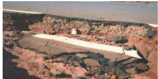
Figura 06: Erosão de borda (SB)
