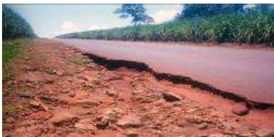
Figura 27: Erosão de borda (SAFL)
