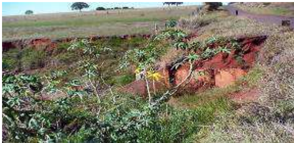
Figura 43: Erosão saia de aterro (laterítico)
