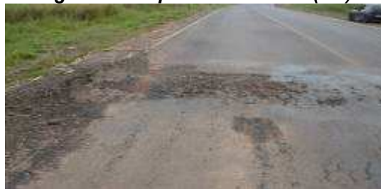
Figura 14: Ruptura Localizada (Granular)
