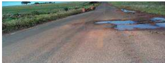
Figura 36: Deficiência drenagem(SB)
