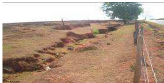
Figura 40: Segmento grande concentração Águas pluviais (bacia retenção)
