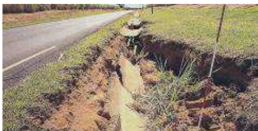
Figura 30: Ruptura de sarjeta (SC)
