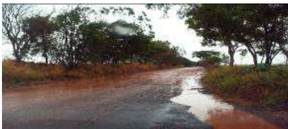
Figura 37: Deficiência drenagem (SAFL)
