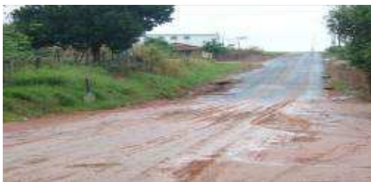
Figura 07: Erosão de borda (SAFL)
