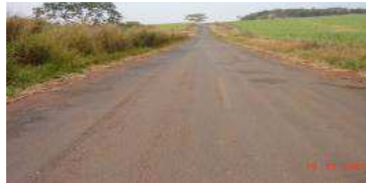
Figura 48: Retirada de Leira (SB)
