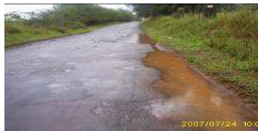
Figura 28: Deficiência drenagem (SB)
