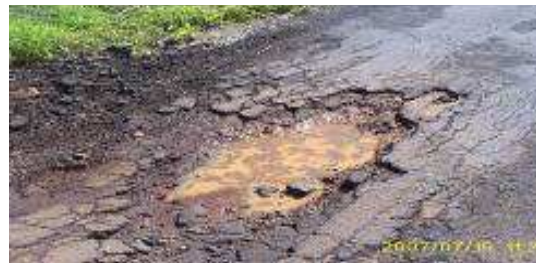
Figura 12: Ruptura Localizada (SB)
