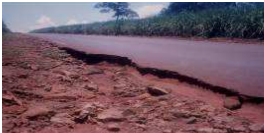
Figura 05: Erosão de borda (SAFL)
