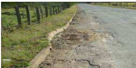
Figura 09: Ruptura de borda (SAFL)
