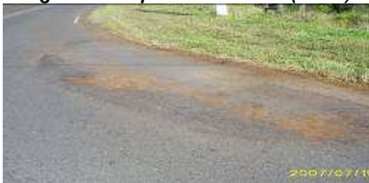
Figura 13: Ruptura Localizada (SC)
