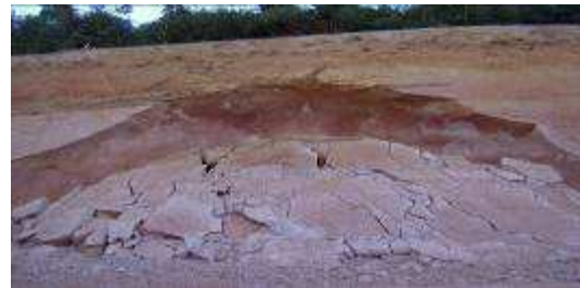
Figura 44: Erosão em corte (saprolítico)
