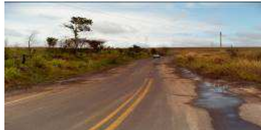
Figura 50: Retirada de Leira (SB)
