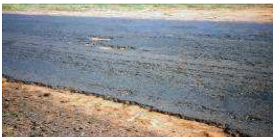
Figura 23: Severidade Mau (SC)
