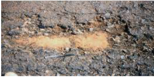
Figura 17: Defeito Revestimento (SAFL)
