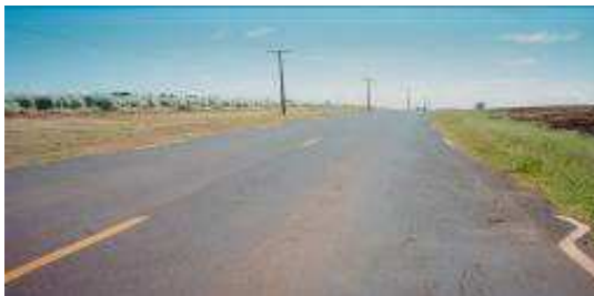
Figura 11: Ruptura Localizada (SAFL)
