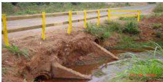
Figura 41: Deficiência de vazão
