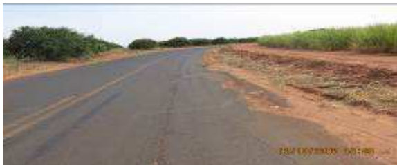
Figura 35: Deficiência drenagem (SAFL)
