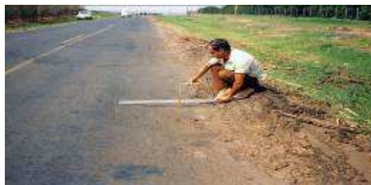
Figura 10: Ruptura de borda (SB)
