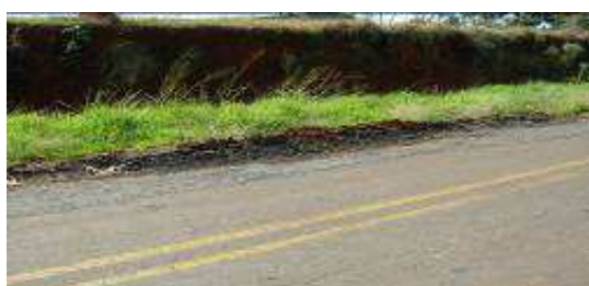
Figura 08: Ruptura de borda (SB)
