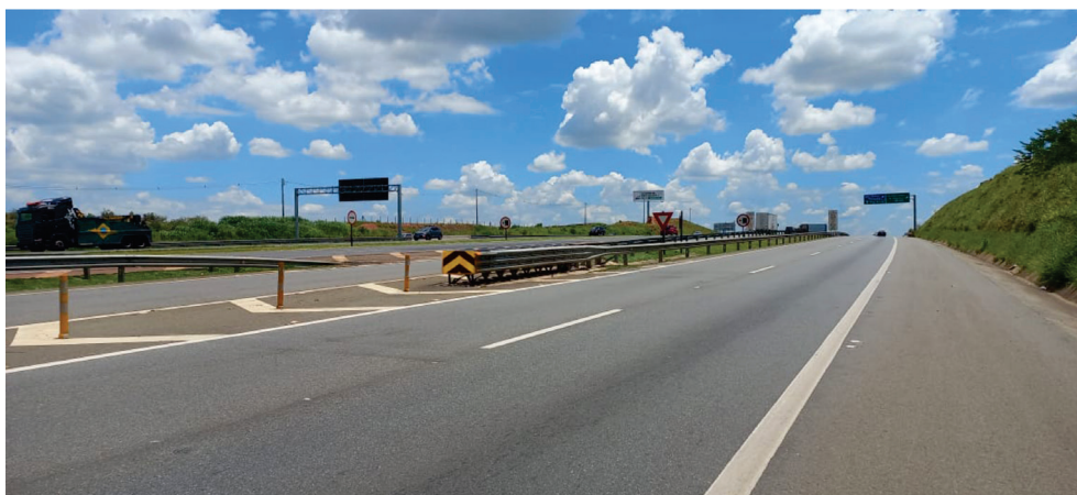
Figura 8.7: Exemplo de uso de dispositivo amortecedor de impacto em bifurcação
