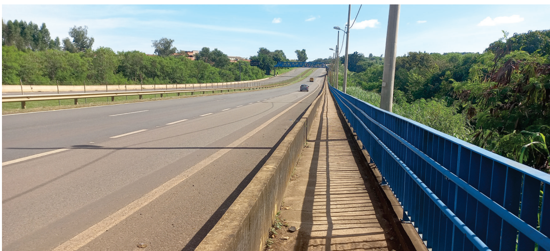
Figura 11.3: Exemplo de passeio segregado para acomodar pedestres e ciclistas em viadutos e pontes
