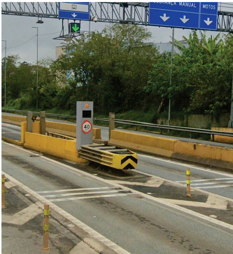
Figura 8.6: Exemplo de uso de dispositivo amortecedor de impacto em praça de pedágio
