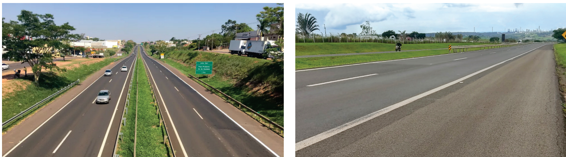
Figura 7.11: Acostamentos com pavimentos diferentes da pista de rolamento
