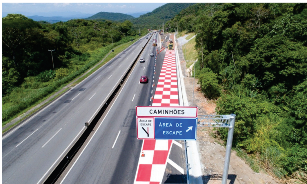
Figura 8.11: Exemplo de rampa de escape para caminhões na rodovia BR-277, Paraná
