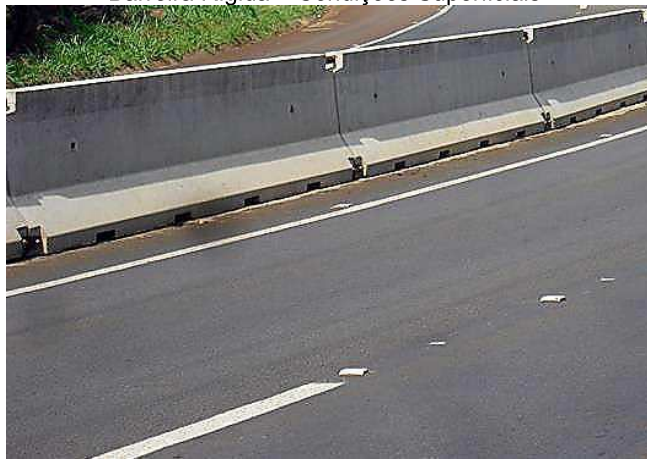
Barreira Rígida – Condições Superficiais
