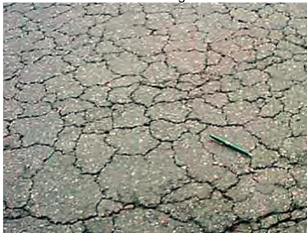
Trincas Interligadas
