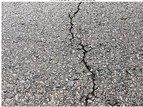
Trincas Isoladas
