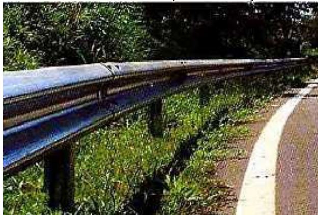
Defensa Metálica – Superfície e Fixações
