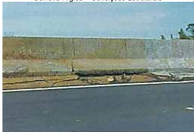
Barreira Rígida – Condições Estruturais
