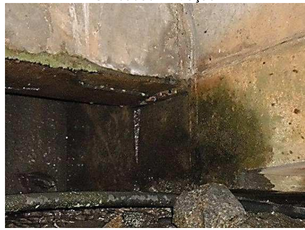
Umidade / Infiltração
