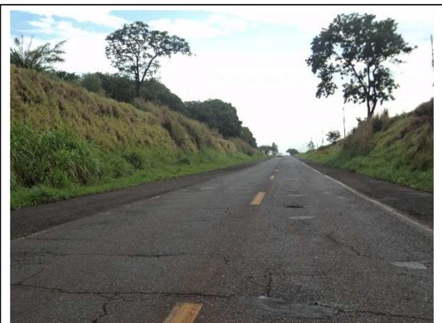
Foto 7.2.3-21: Talude de corte com cobertura vegetal, o qual sofrerá intervenções para a execução do empreendimento.
