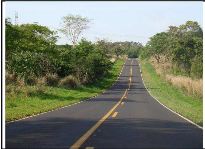
Foto 3.1-2: Vista geral do trecho. Nota-se pavimento e pintura de sinalização em bom estado de conservação.
