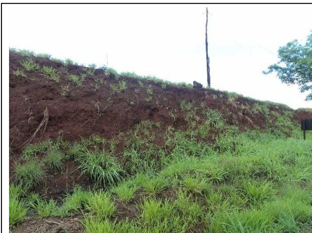
Foto 7.2.3-20: Talude existente no trecho em questão, o qual apresenta solo exposto, sem proteção vegetal do solo.
