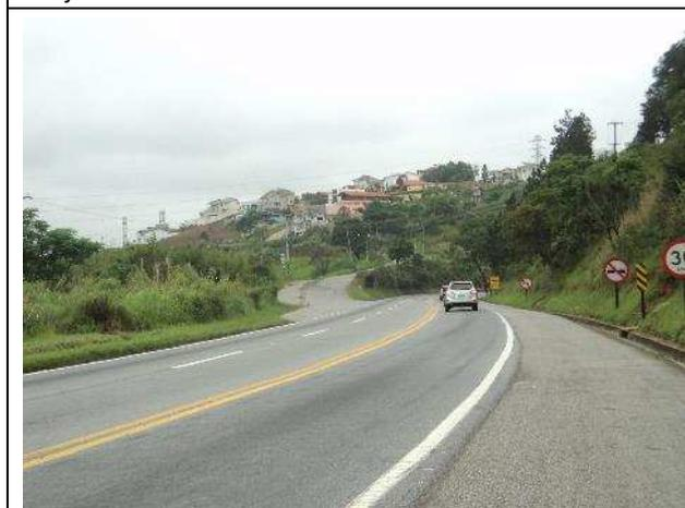
Foto 7.2.1-5: Vista geral do trecho a ser duplicado, com curva perigosa. Haverá necessidade de corte de talude.
