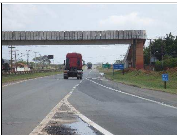
Foto 2: Vista geral do início do Lote 01 – km 169+000
