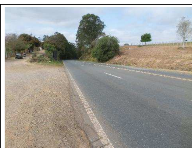
Foto 26: Local de execução de corte para implantação da pista nova – km 200+000.
