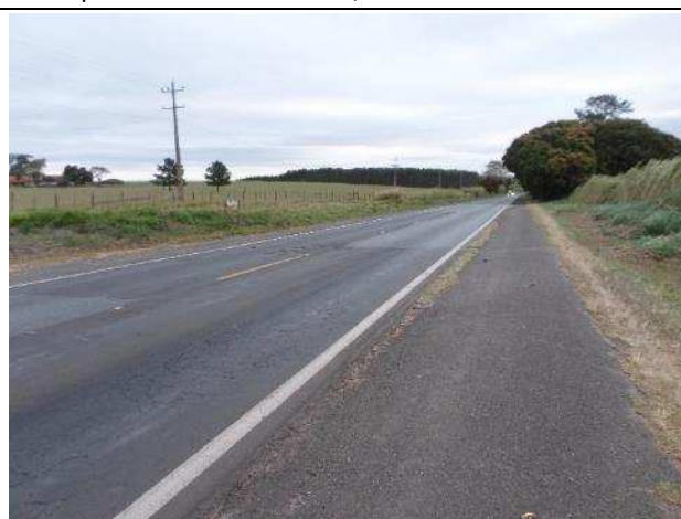
Foto 20: Árvores a serem suprimidas para implantação de dispositivo de acesso e retorno – km 267+500, lote 04
