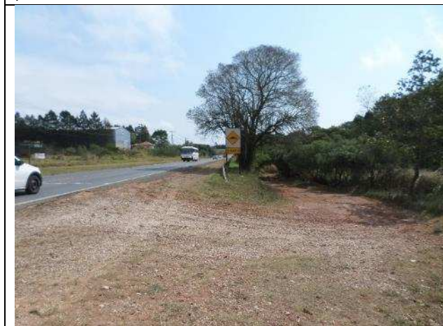
Foto 27: Local de execução de aterro para implantação da pista nova – km 204+100.
