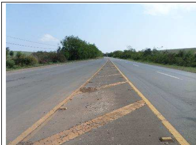
Foto 11: Vegetação em estágio inicial a ser suprimida – lado esquerdo – km 173+200, lote 01
