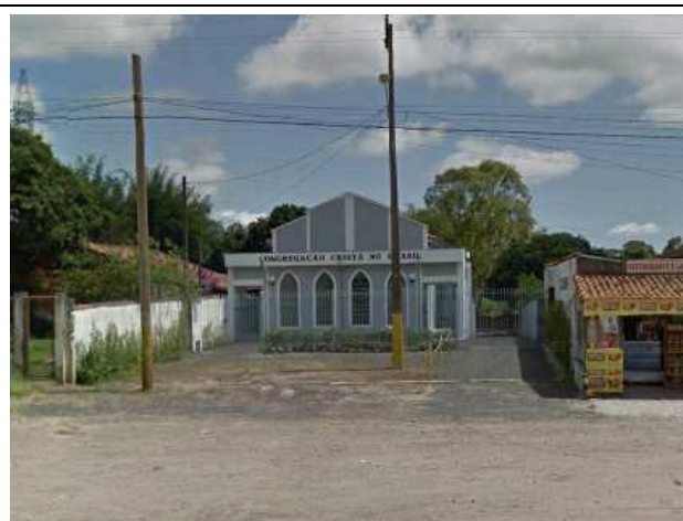
Foto 32: Igreja no bairro Boa Vista – km 200+620, lado esquerdo.
