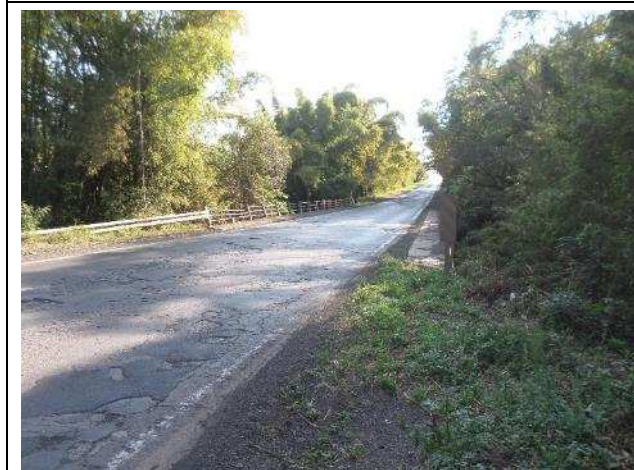
Foto 23: Vista geral da APP do Ribeirão Santa Helena – km 234+700, lote 03
