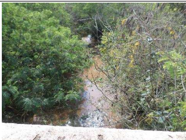
Foto 5: Vista geral da Ponte Alta – km 169+993, lote 01
