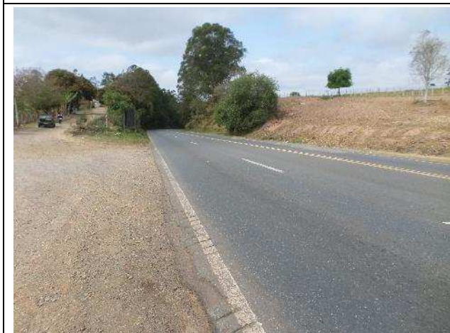
Foto 13: Árvores a serem suprimidas para implantação de dispositivo – km 200+240, lote 02
