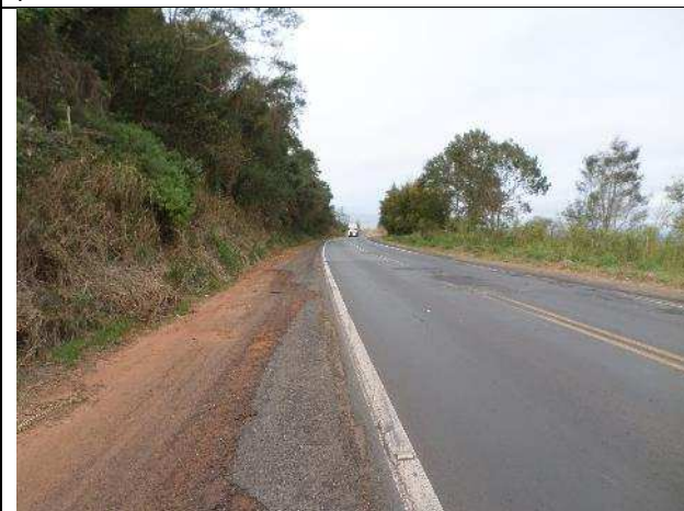
Foto 28: Local de execução de corte (lado esquerdo) e aterro (lado direito) para implantação de dispositivo – km 262+000.
