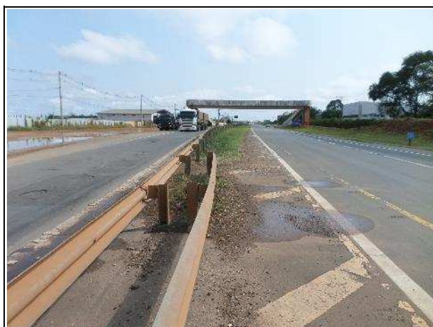
Foto 1: Vista geral do início do Lote 01 – km 169+000
