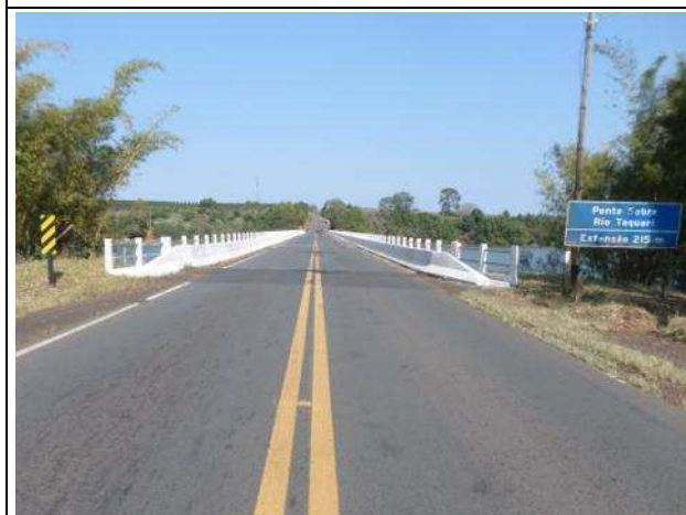
Foto 3: Vista geral do final do trecho na DR.02 – km 295+400
