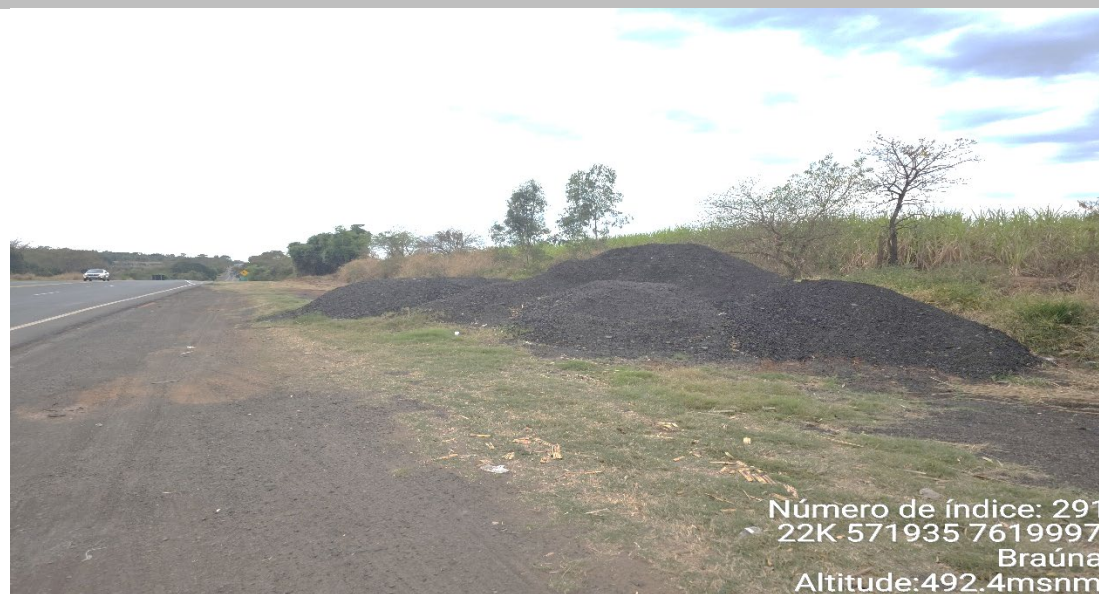
Foto 14 - Km 312+200 – LE – Depósito de Material Excedente – DME nos limites da faixa de domínio com material fresado e sem a devida identificação e cercamento.
