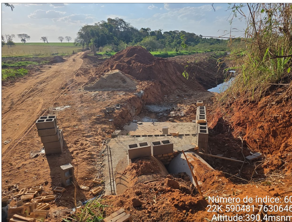
Foto 9 - Obra de drenagem em curso em área rural, sobre solos avermelhados derivados de arenitos do Grupo Bauru, que demandam atenção geotécnica quanto à estabilidade de taludes e fundações.
