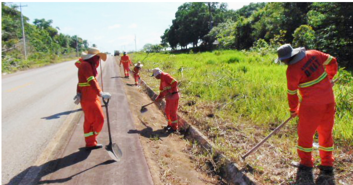
Limpeza do Sistema de drenagem
