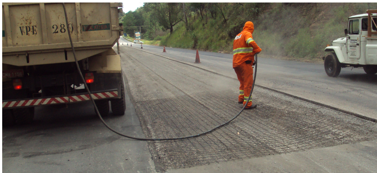
Colocação e fixação da tela e aplicação da pintura de ligação. Utilização de soprador (compressor de ar) para retirada de impurezas no aguardo da pintura de ligação
