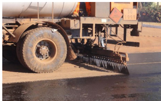
Lançamento da pintura de ligação utilizando barra espargidora.
