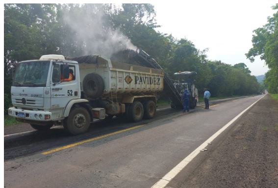
Fresagem de pavimento com fresadora e recolhimento de resíduos asfálticos
