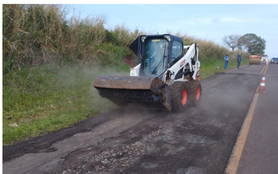
Limpeza do material residual com utilização de equipamento varredor para mini carregadeira.
