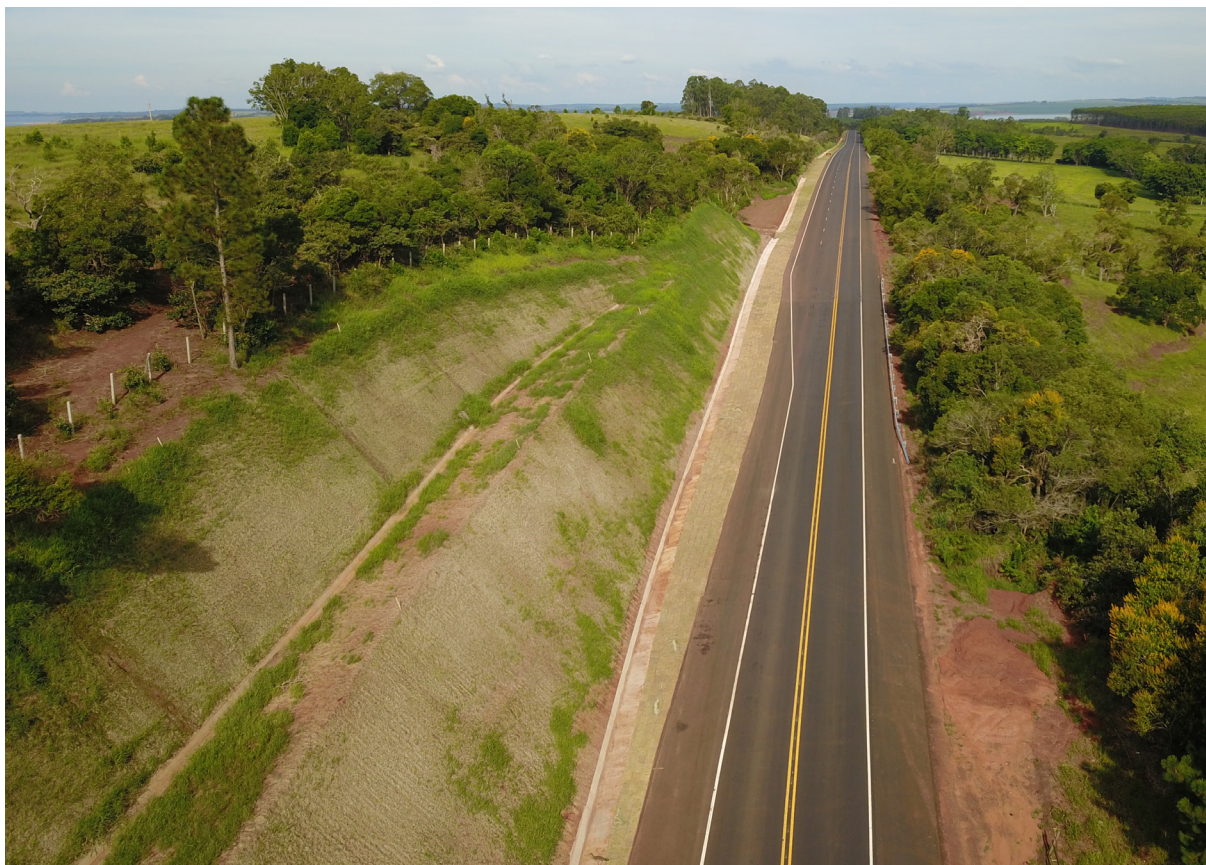
Talude estabilizado com eliminação de erosões
