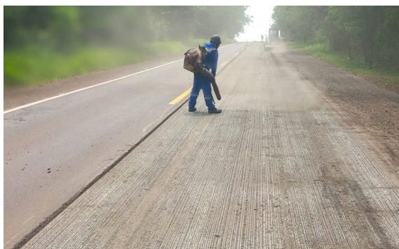
Limpeza do material residual com utilização de soprador de ar
