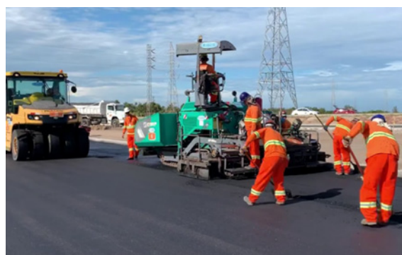
Lançamento da massa asfáltica CBUQ
