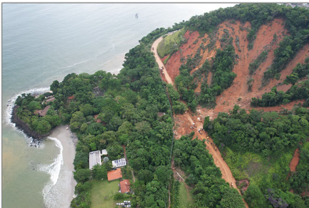
Figura 17 - Rodovia SP 055 km 164 (São Sebastião)
