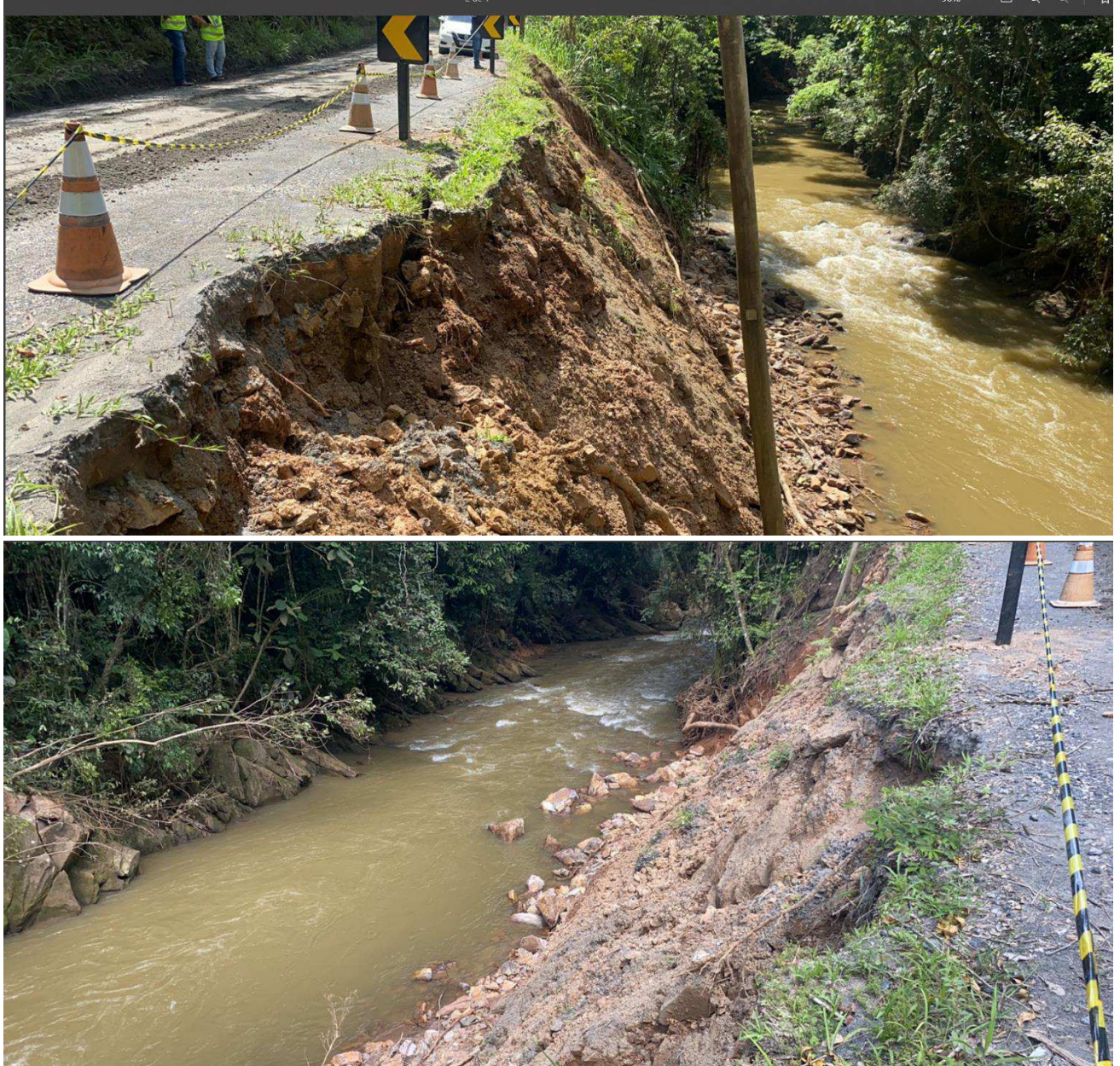
Figura 4 – Fotos tiradas no local do sinistro, com exposição do subsolo local.
